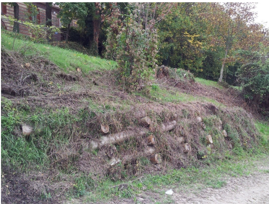
Figura 9 – Palificata esistente. Fotografia del 2013.
